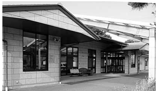
デイサービスセンター等を併設した西部保健福祉サービスセンター 棟続きの右奥は国保診療所
